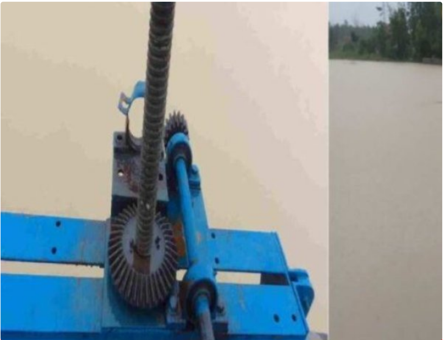
Pintu air Albaret Simpang Mesuji
